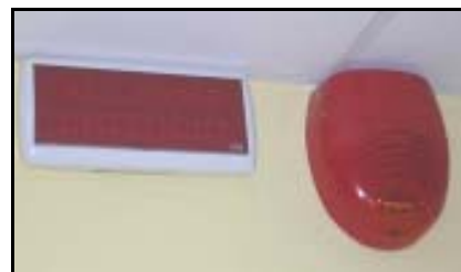
Allarme ottico-acustico di incendio.
